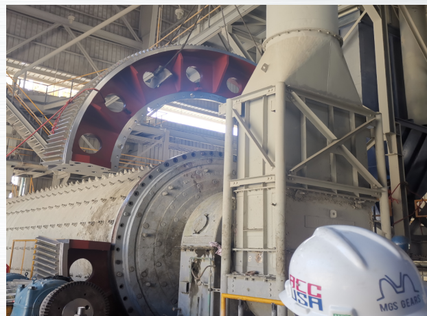
Momento en que eran ensambladas las dos mitades de la corona, con posterioridad al control y limpieza de la brida.
